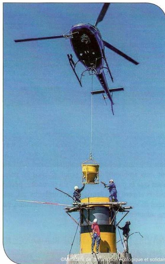
© Ministère de la transition écologique et solidaire Pour entretenir ou reconstruire certaines tourelles, il faut amener le béton par hélicoptère. Autant s'assurer avant qu'elles sont toujours indispensables.
