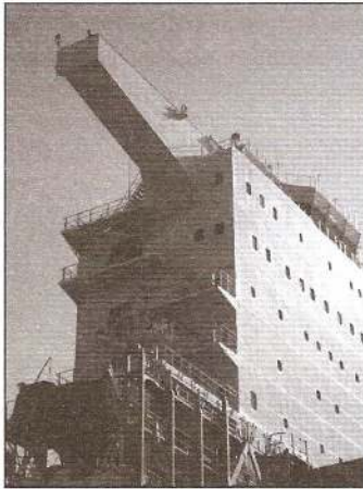
Figure 5 : Passerelle à 54 m au-dessus du niveau de l'eau
