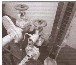
Une cale en bois bloque la vanne en position d'ouverture.
