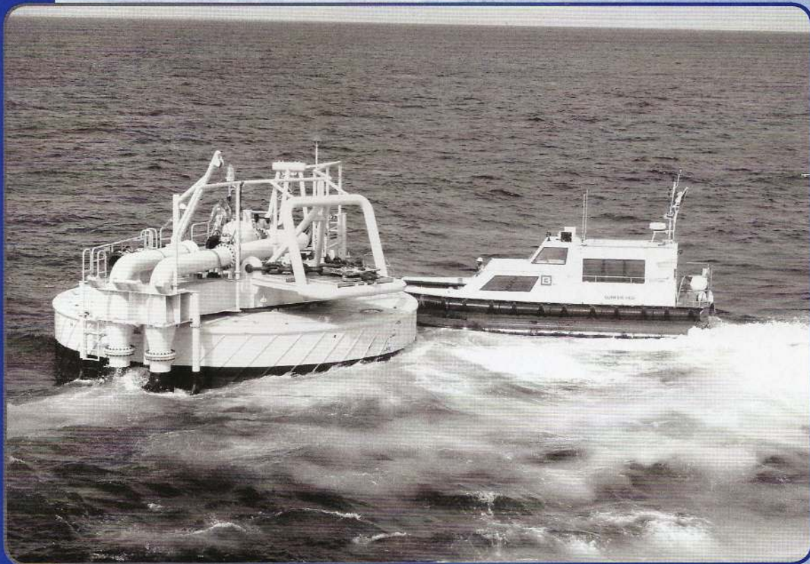
Bouée de chargement du FSO PALANCA - Angola
