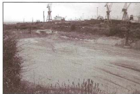
12. Le bassin a été vidé
