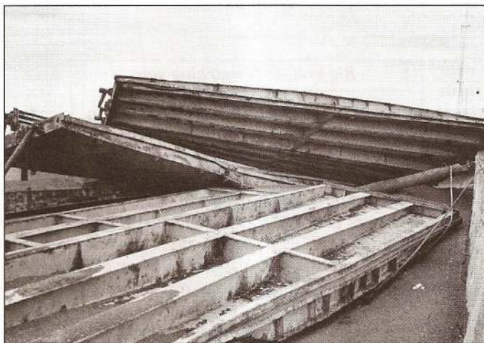
"Palatio Uno". Panneaux de cales soufflés par une explosion (Photo J. Loiseau)
