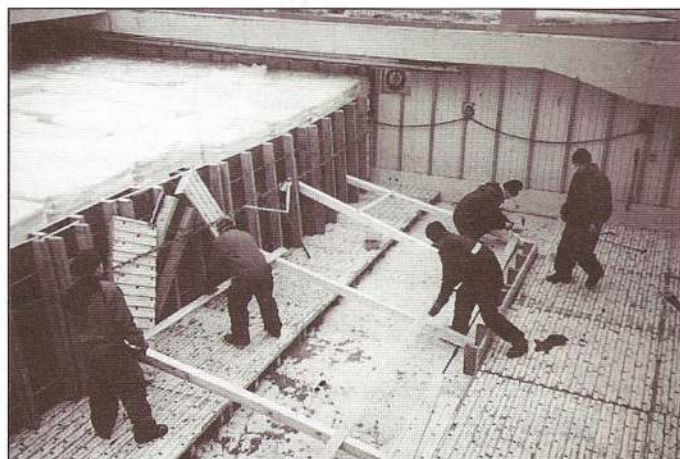
Accorage de palettes en faux pont
